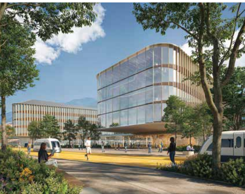
Veduta esterna del futuro ospedale - Per gentile concessione Spedali Civili di Brescia
